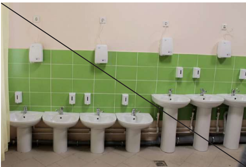
Раковины на пьедестале не рекомендуется использовать, так как они не учитывают ростовые группы и ими неудобно/невозможно пользоваться людям, передвигающимся с помощью ТСР
