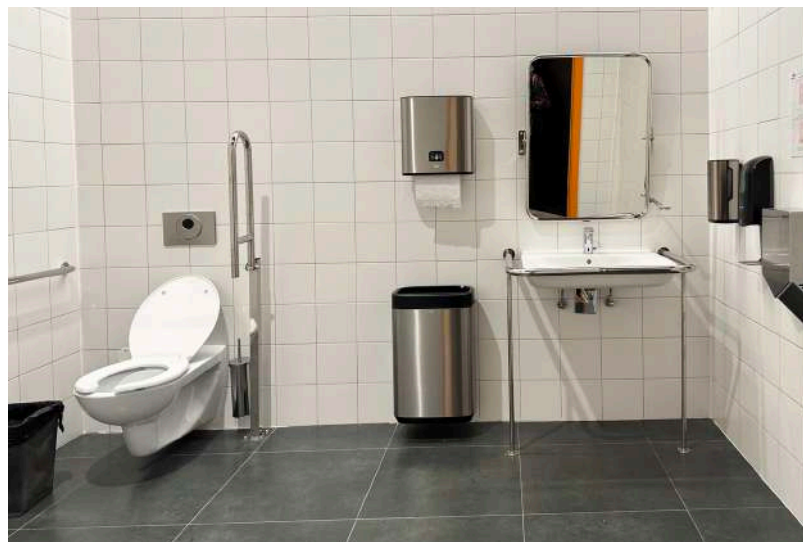
«Новая школа», г. Москва Санузел для МГН и гостей. Все элементы подвесные, что значительно упрощает уборку
