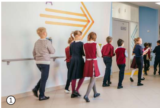
1. Поручни вдоль стен являются поддержкой для людей с нарушениями опорно-двигательной системы и с нарушениями зрения
