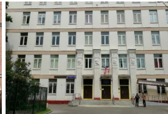
Коррекционная школа № 825, г. Москва
