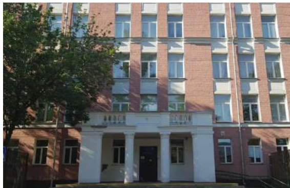
Коррекционная школа № 79, г. Москва
